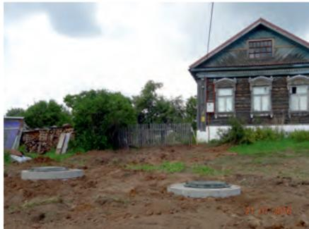
Es gibt jetzt auch zwei Schächte vor dem Haus, einer für das Wasser, einer für das Abwasser. Eine elektrische Pumpe am Wasserschacht versorgt die Nachbarschaft mit Frischwasser, da sie keine Leitungen ins Haus haben.
